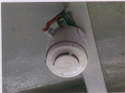
Sistemas contra incendio, gracias a las bombas de agua a presión, el agua llega hasta la última planta, donde se reserva una cantidad importante en caso de incendio.
