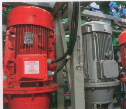
La Torre Eiffel tiene un total de 19 transformadores de alta y baja tensión.
