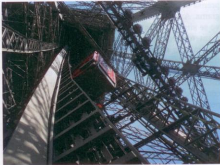
Los equipos que requieren más mantenimiento de la Torre Eiffel son aquellos que generan más dinero y beneficios para la torre: los ascensores.
